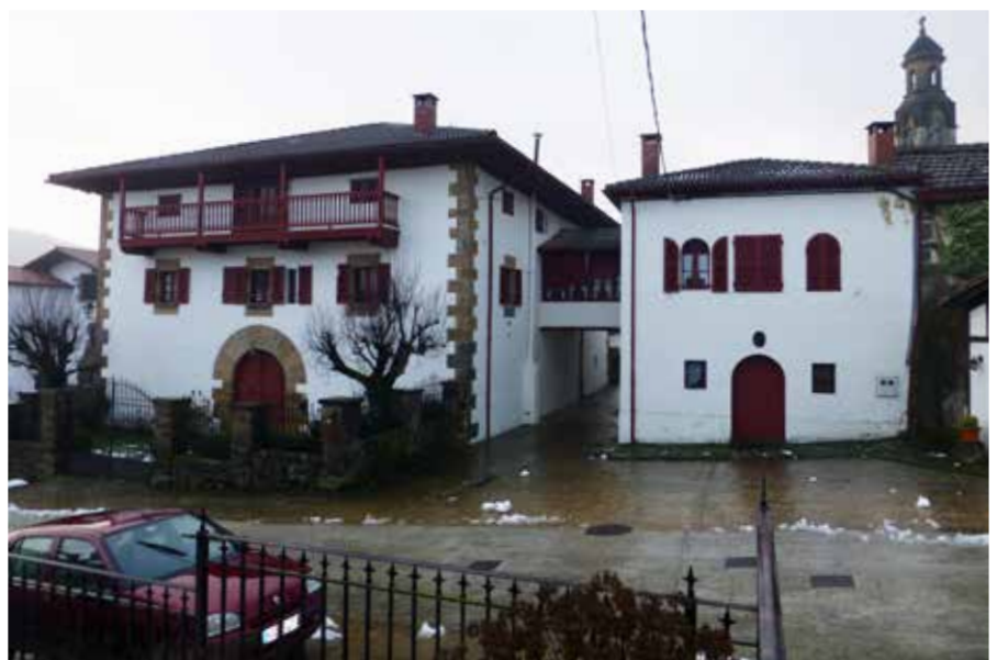
▲ Etxeberria eta Etxettikia, galeria batekin lotuak.
